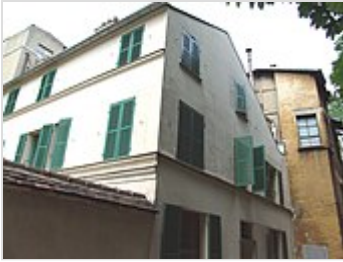
Maison de Balzac, 47, rue Raynouard, Paris
